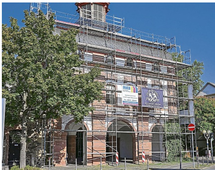
Einst repräsentativer Stadteingang: Das Bauwerk ist bereits eingerüstet.
